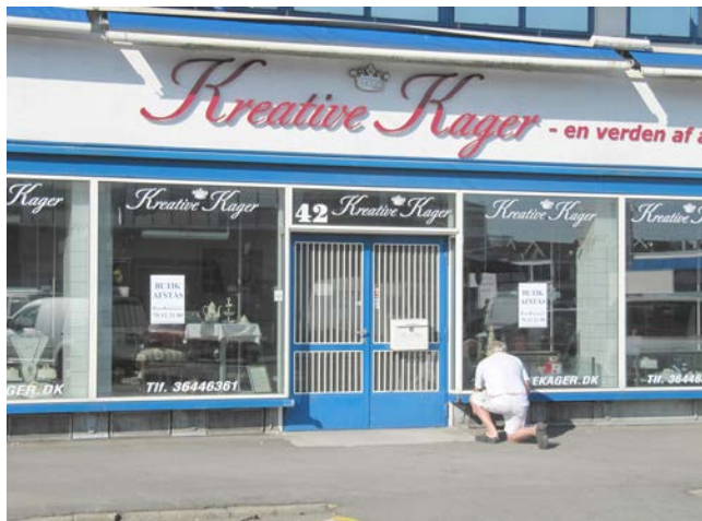
Den Hvide Kødby. Bygningsdetaljer.
