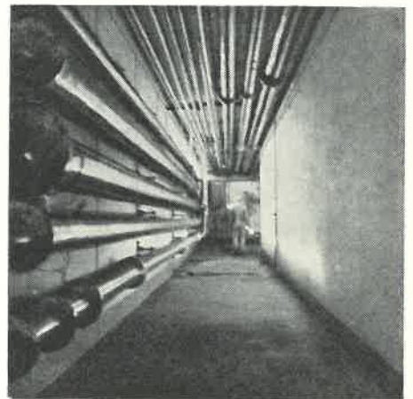
Kældergang i Maskinhus
