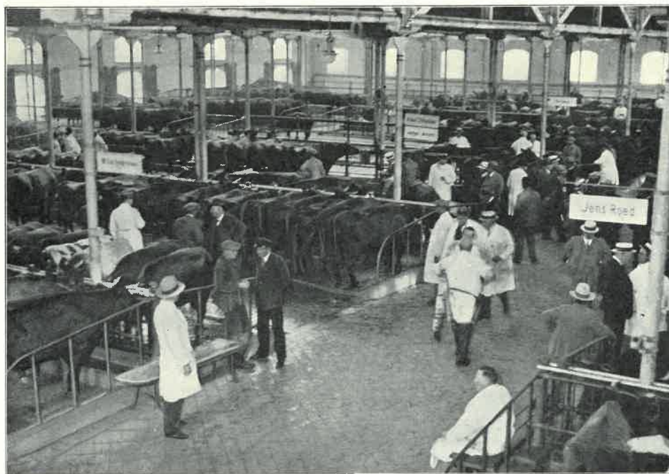
Salgshallen for Storkreaturer. (Gulvflade: 5250 m 2 ; Opbindingsplads til 1600 Kreaturer.)
