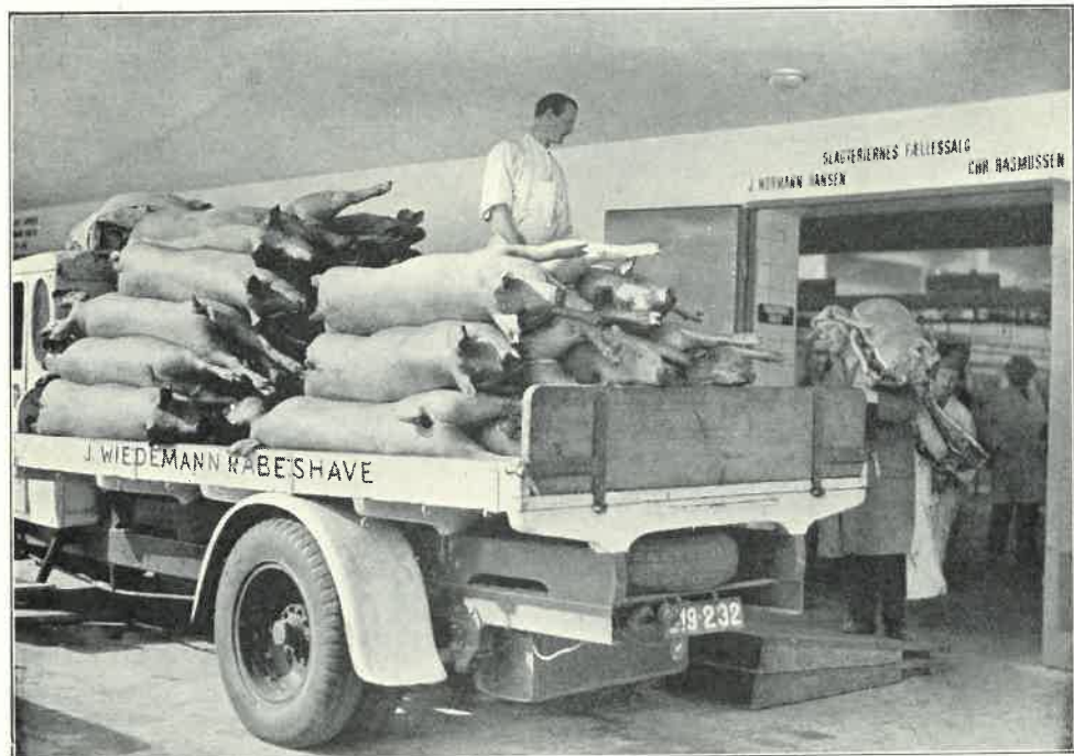
Under Flæskhallens Læssetag.
