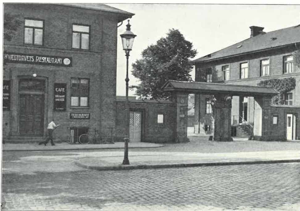
Hovedindgangen til Kvægtorvet fra Halmtorvet. (Til højre: Administrationsbygningen).
