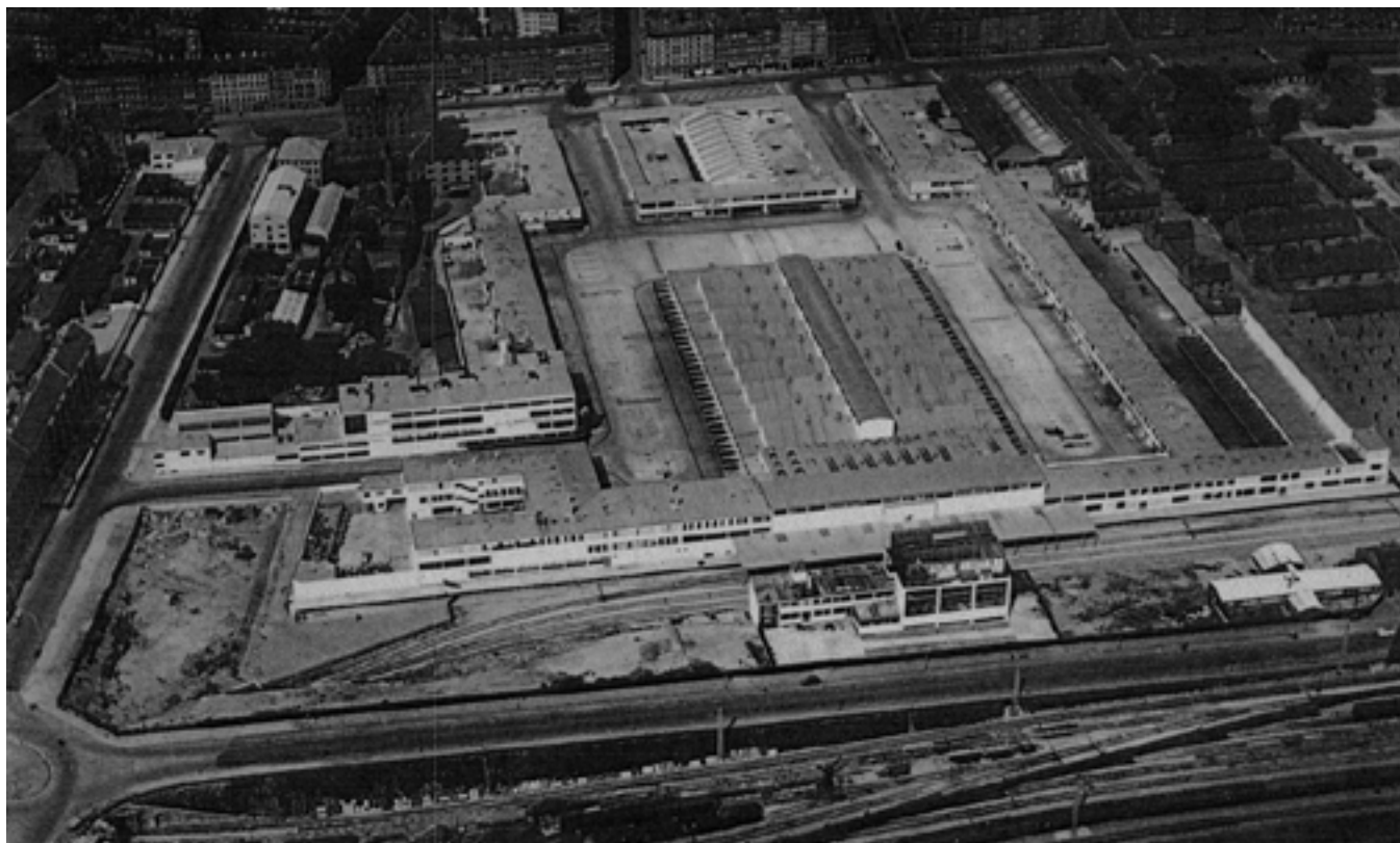
Den oprindelige Hvide Kødby. Køresporet anes nederst, og der er ikke bygninger langs Ingerslevsgade samt arbejdsformidlingen. 1934.
